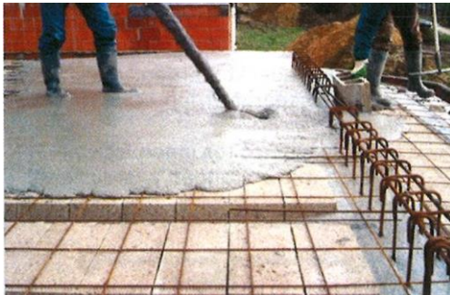
Abbildung 1: Ein sehr geringer Einsatz von Eisen beim Kunstfaserbeton (Quelle: BRICONA met GmbH)
