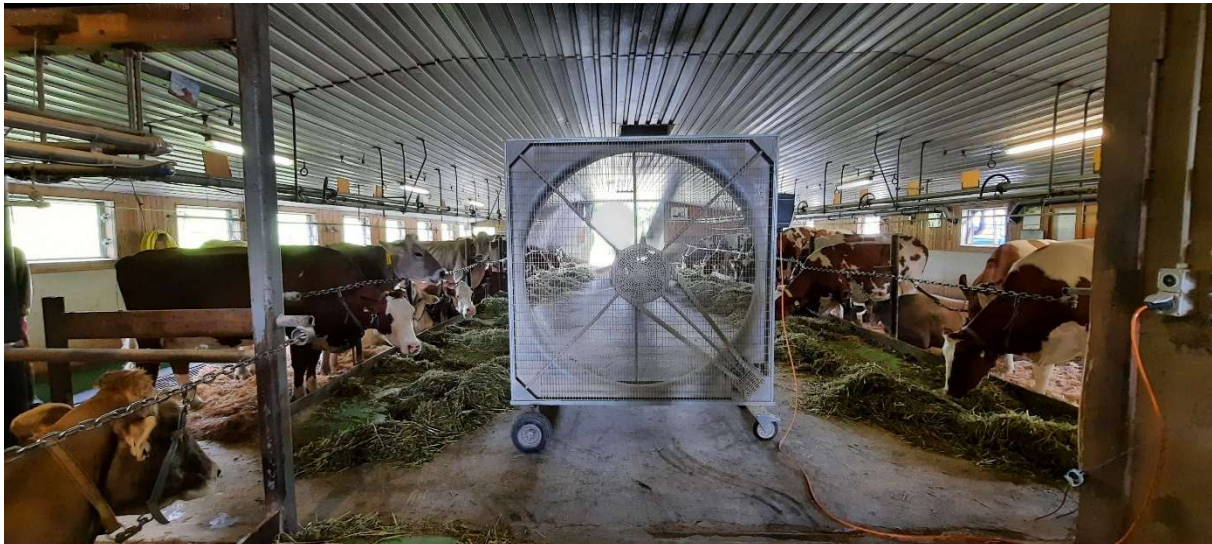
Abbildung 1: Im Anbindestall kann das Stallklima mit einem Grossraumventilator verbessert werden. Bereits ab 10°C sollte er täglich 24 Stunden in Betrieb sein. (Quelle: Strickhof)
